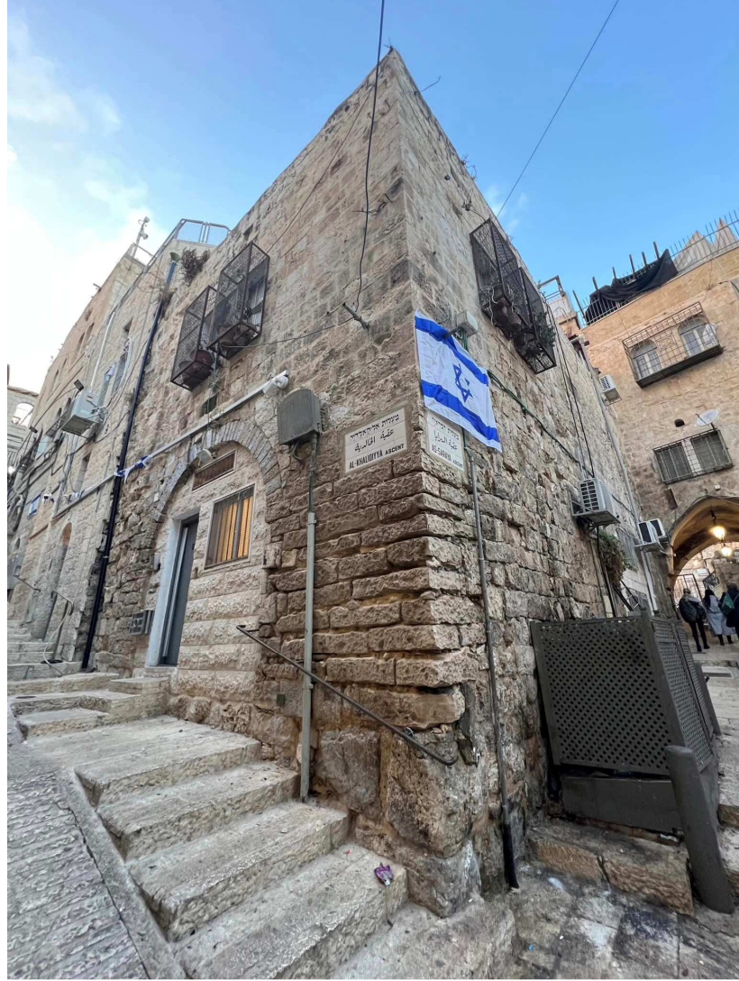
مسكن عائلة صب لبن المستولى عليه من قبل جمعيات استيطانية - البلدة القديمة تموز 2023
