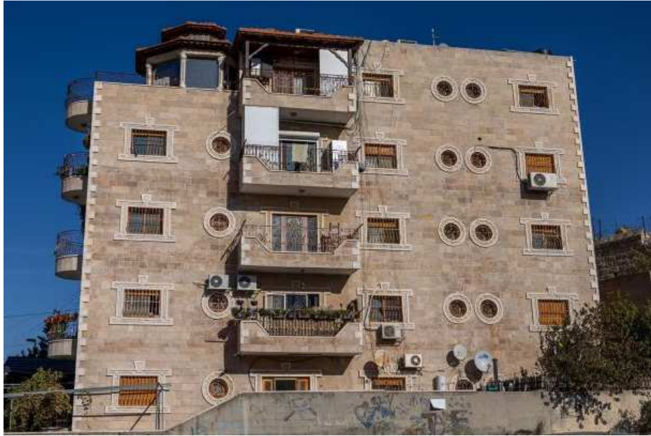
بناية مهددة بالهدم بحجة عدم الترخيص في حي الصوانة بالقدس - بنيت عام 1998
