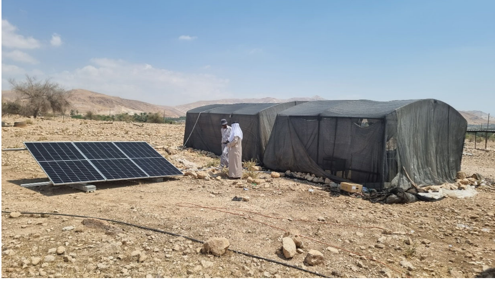
محافظة أريحا والأغوار - فصايل : تزويد التجمعات البدوية بوحدات إنتاج الطاقة الشمسية لتشغيل آلات حلب الأغنام
