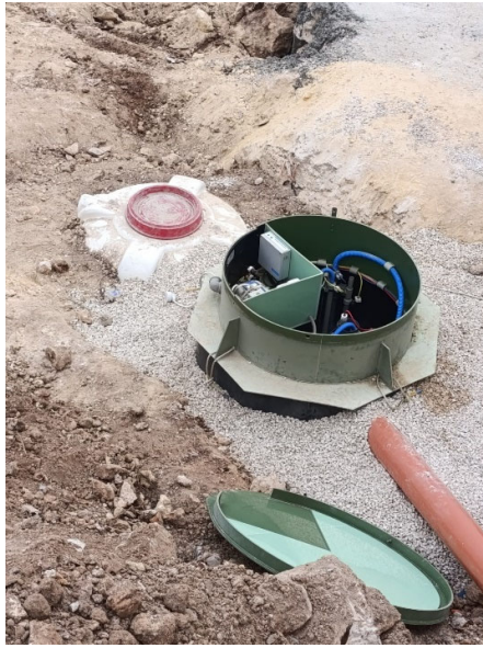
وحدات معالجة مياه الصرف الصحي المنزلية، بديل للحفر الامتصاصية / Domestic wastewater treatment units, an alternative to cesspits.
